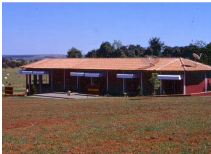
Auditório e refeitório em construção
